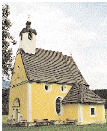
Außenansicht der Wallfahrtskapelle
