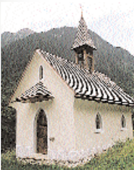
Außenansicht der Bruder Klaus-Kapelle
