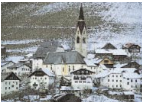
Die Wallfahrtskirche im Zentrum von Enneberg
