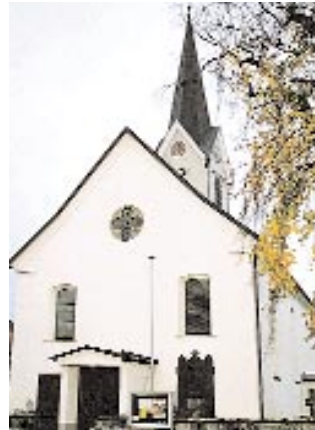
Außenansicht der Pfarrkirche Hl. Georg in Hohenweiler
