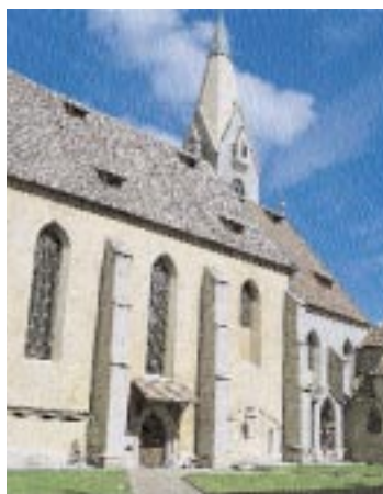
Die Stadtpfarrkirche St. Michael mit Blick auf das Rundbogenportal
